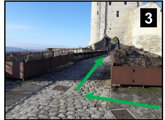
3 Pont à franchir pour accéder au parc.
