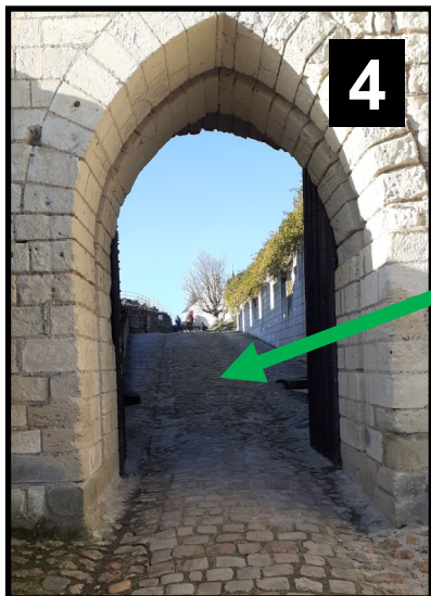
4 Rampe d'accès au parc. Largeur de la porte : 2 m 40.
