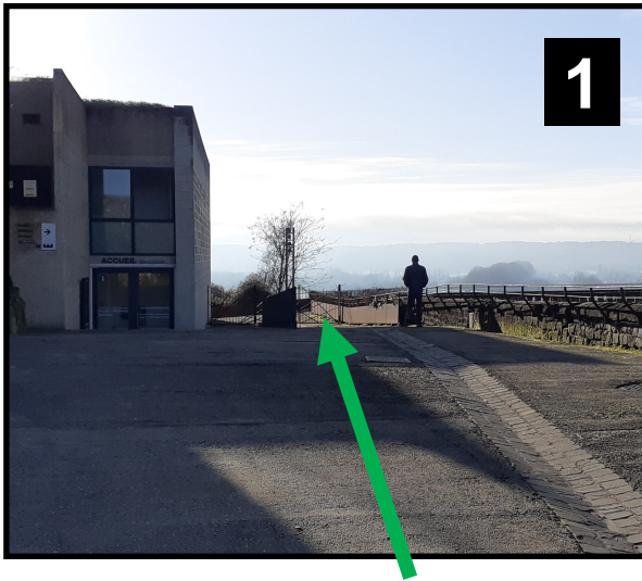
1 Accès vers le pont qui mène au parc de la Forteresse.
